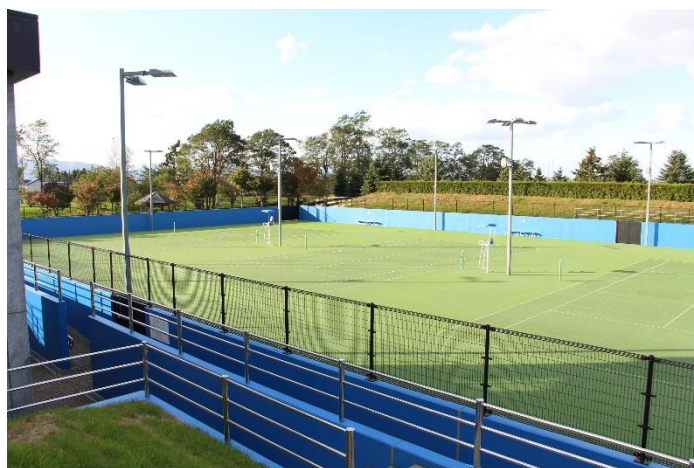
令和2年度に改修工事を行った市営テニスコート
