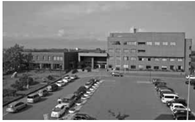
耐震改修工事等が行われる公民館
