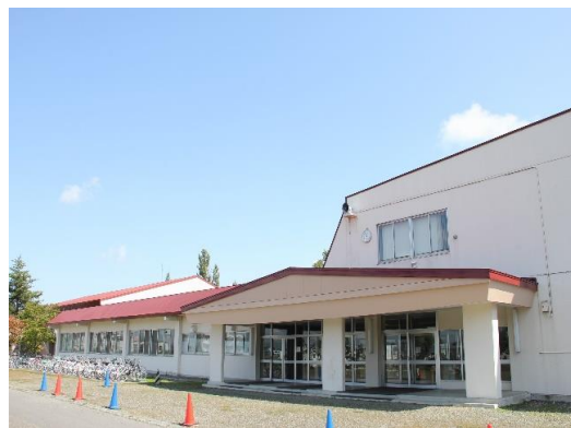
外観(生徒玄関側)
